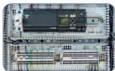
Elektrotechnik Elektroniker/in Betriebstechnik
